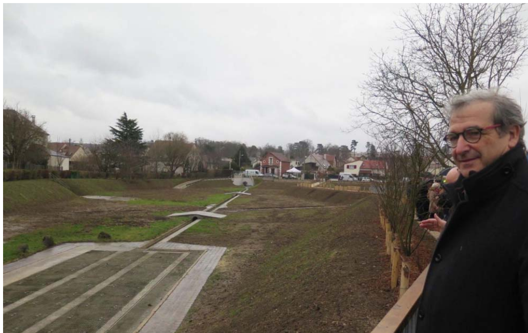
Saint-Prix, le 3 février 2017. Jean-Pierre Enjalbert, le maire (DLF) de Saint-Prix et président du SIARE, a inauguré le nouveau bassin de retenue des eaux pluviales de la rue Robert Thomas. LP/A.B.
